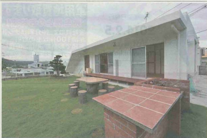
レンガ造りのバーベキュー台はご主人の手作り。夜も庭で食事ができるよう、軒下にスポットライトを設置しました。Sさん宅は高台にあるため、周囲からの視線も届きにくく、心置きなく語らいが楽しめます
